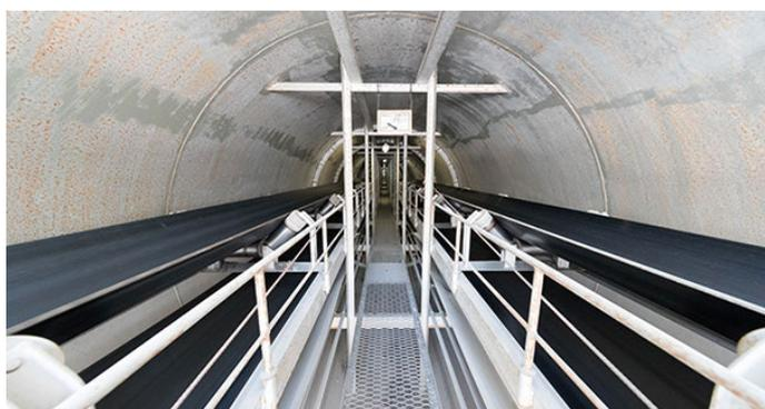
骨材供給ベルトコンベア
